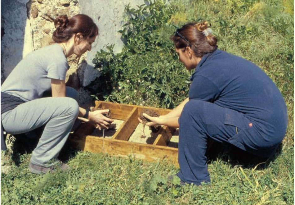
Foto 14. Realización de adobes.
