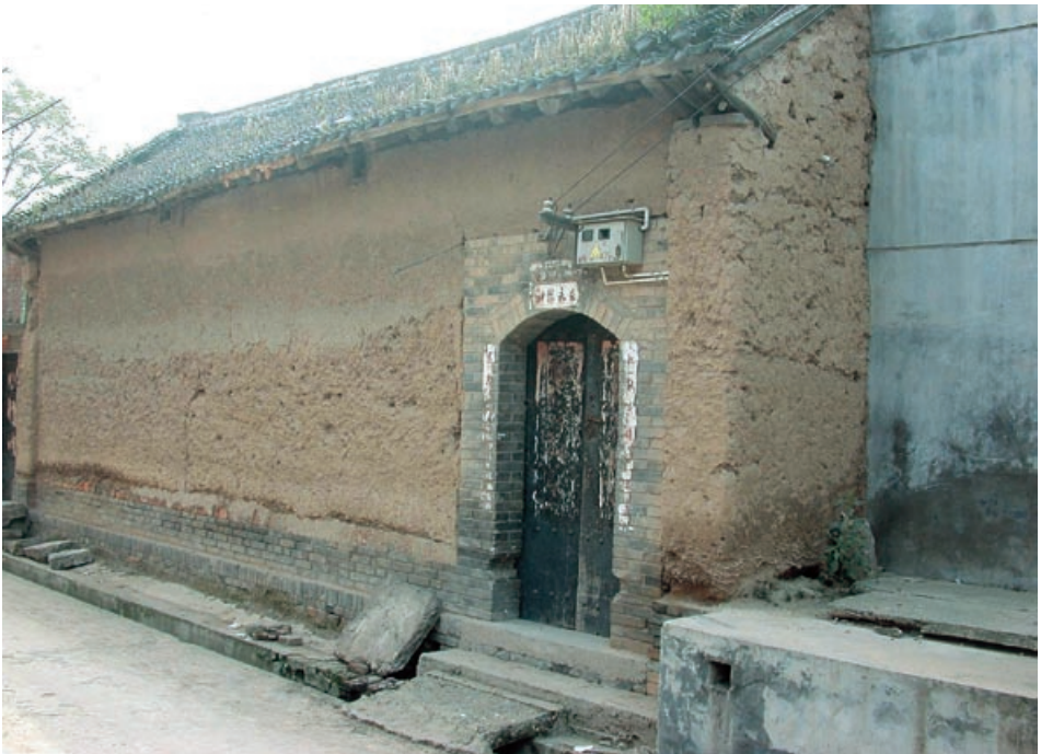
Foto 11. Vivienda de adobe en el poblado de Nanchi.
