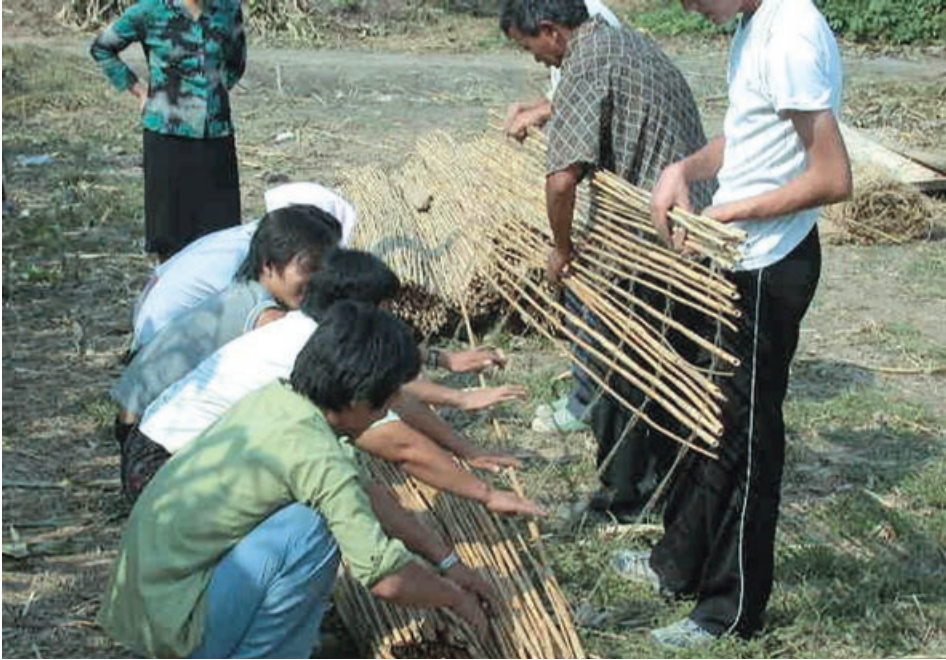
Foto 8. Operarios trabajando para la predisposición de las esteras utilizadas para la cubierta.
