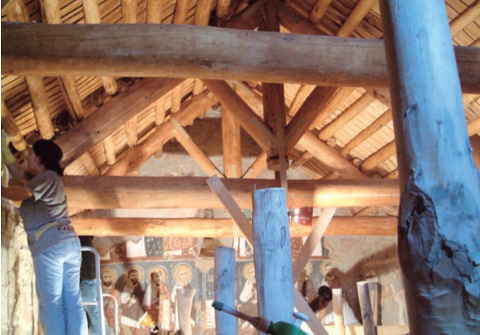
Foto 3. Interior de la iglesia en el monasterio de Mar Musa, durante el taller didáctico para la restauración de las pinturas murales y de la cubierta en adobe.
