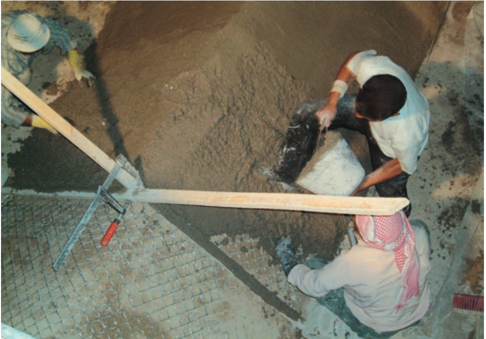
Foto 5. Compactación de la tierra en correspondencia con la cubierta del techo de la nave central de la iglesia del monasterio.
