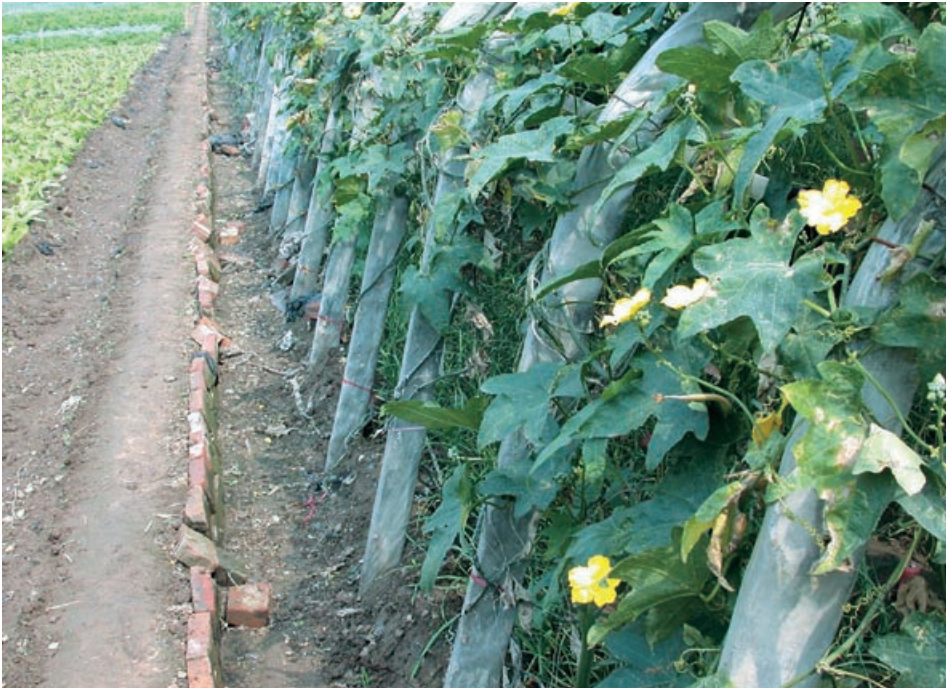
Foto 9. Canalización de las aguas a los lados de la cubierta provisional.
