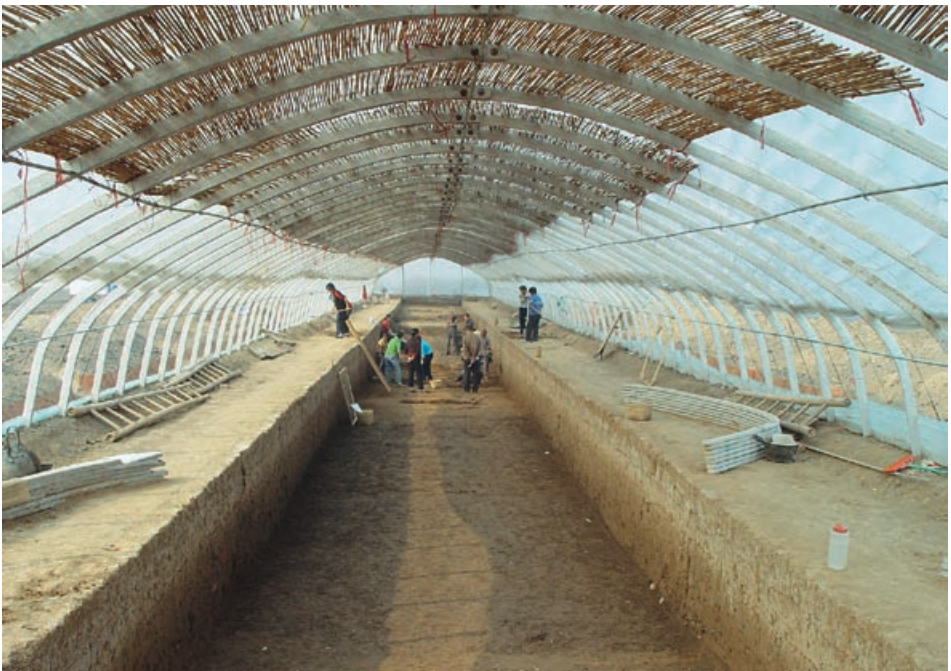
Foto 6. Invernadero para el cultivo en los campos de Nanchi, cerca de Luoyang, China. Estructura de vigas conectados por tirantes, altura de m. 3,5 luz ocluida m. 8.
