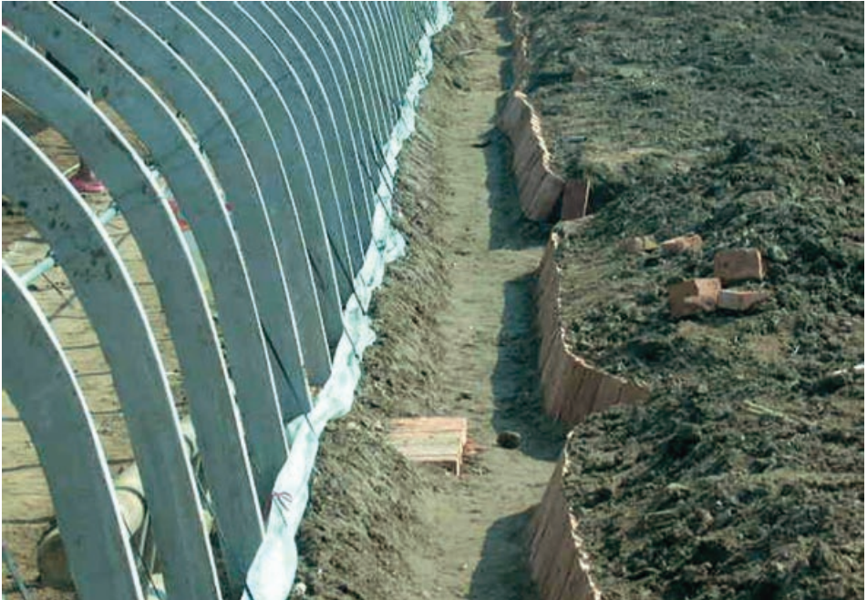
Foto 10. Organización de las tierras en áreas separadas para permitir la eliminación de las aguas y facilitar el acceso al yacimiento.
