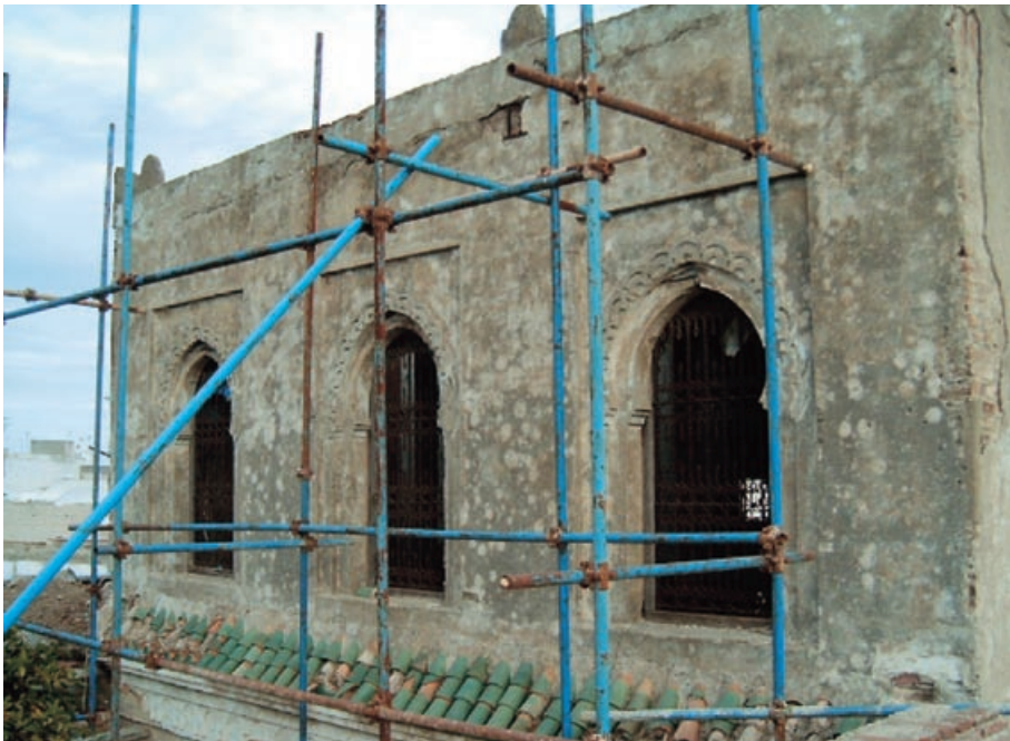
Foto 4. Rehabilitaciones del Teatro Nacional.
