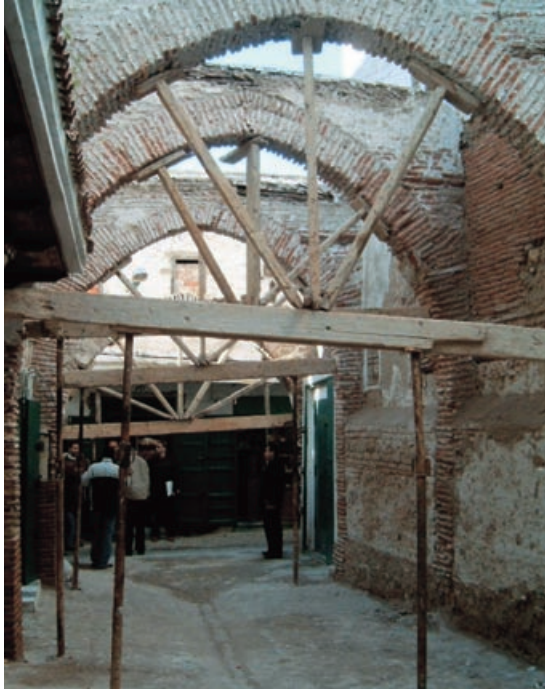
Foto 3. Rehabilitaciones del Teatro Nacional.
