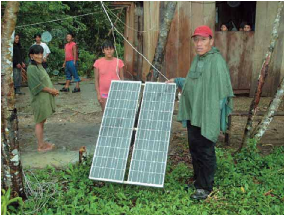
Proyecto de electrificación en comunidad indígena.
