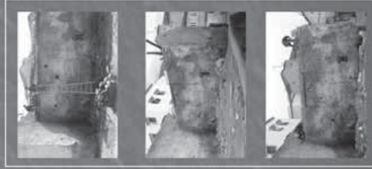
Retirada de la antigua estructura
