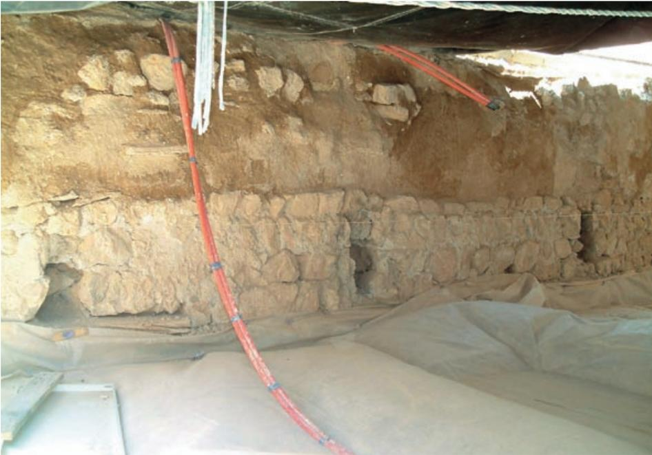
Foto 4. Consolidación de la base de la cubierta en tierra del monasterio, in correspondencia de la cubrición de los triforios.
